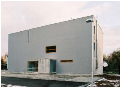
Obr. / 35 Fasáda s hlavním vstupem
