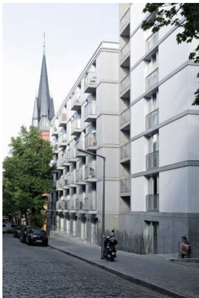
Obr. / 64 Městský charakter domu směrem do ulice
