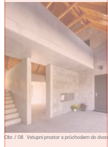
Obr. / 08 Vstupní prostor s průhledem do dvora
