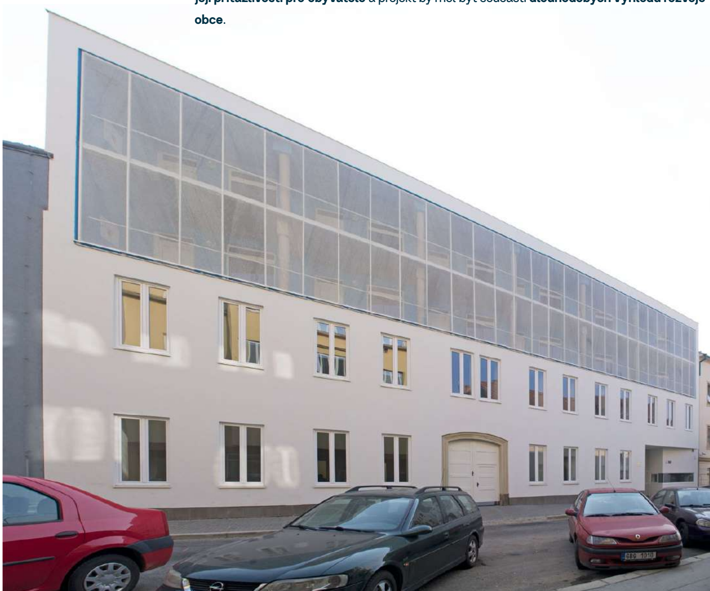
Obr. / 84 Rekonstrukce bytového domu Francouzská v Brně / Atelier AGP
