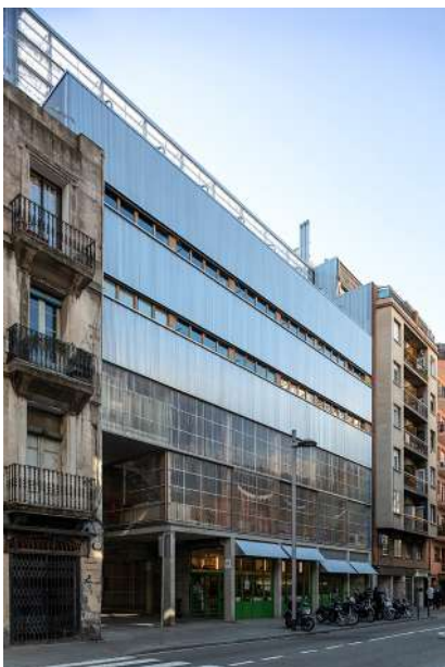
Obr. / 71 Městský charakter domu směrem do ulice
