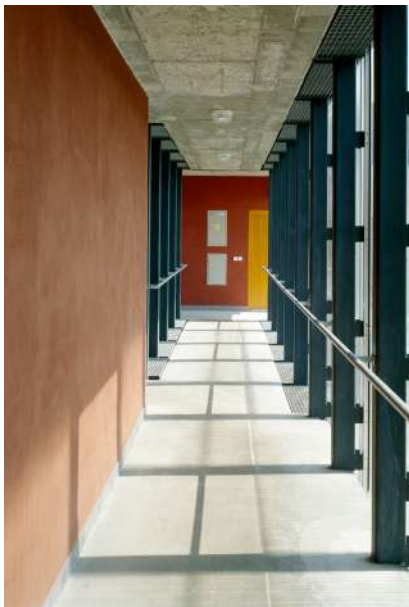
Obr. / 22 Přístup do bytů přes venkovní pavlač
