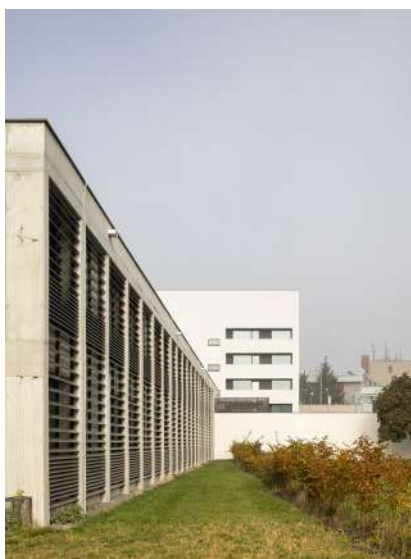
Obr. / 29 Fasáda části parkovacího domu
