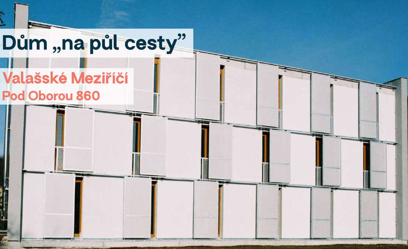
Obr. / 34 Hlavní fasáda s posuvnými slunolamy
