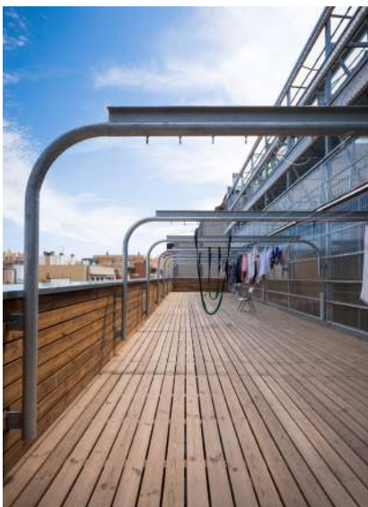
Obr. / 73 Společná venkovní pobytová terasa
